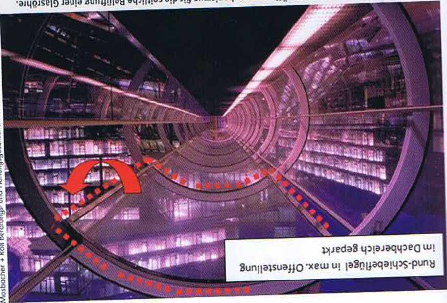
Abbildung 2: Elektro-mechanischer Öffnungsmechanismus für die seitliche Belüftung einer Glasröhre. Einzelne gebogene Glasssegmente können mit Hilfe eines Getriebemotors und mit einem in die gerundeten Pfostenprofile verdeckt eingebauten Beschlag stufenlos in den Dachbereich der Glasröhre gefahren werden.
