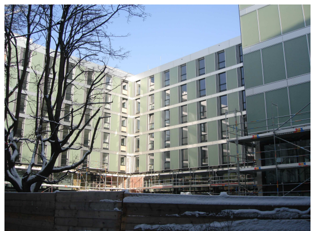
Bild 5: diverse Außen-Ansichten der neuen Fassadenkonstruktion / grüne Flächen = opake Wandflächen-Bekleidungen mit hinterlüfteten Strukturglas-Elementen
