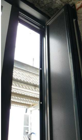
Bild 6: schmaler Paneel-Flügel mit schall-absorbierender Lochblech-Oberfläche
