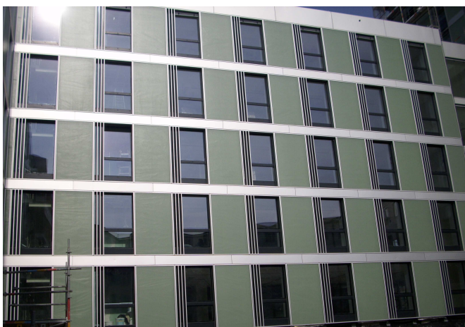
Bild 5: diverse Außen-Ansichten der neuen Fassadenkonstruktion / grüne Flächen = opake Wandflächen-Bekleidungen mit hinterlüfteten Strukturglas-Elementen
