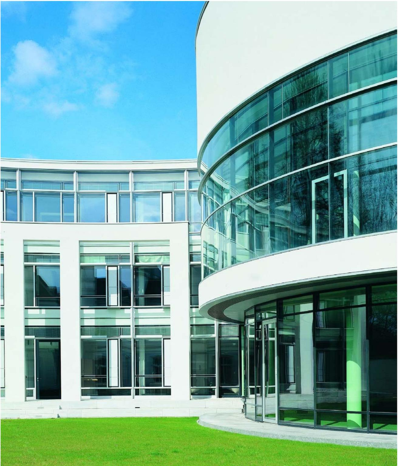
**Ganzglas-Wendeflügel zur Abluffführung** \* Die Belüftung des Fassadenzwischenraumes erfolgt mit einer unsichtbar integrierten und regulierbaren Zuluftöffnung im Fußpunkt der Fassade, die aus nach unten aufklappbaren Blechklappen, (angetrieben über einen Spindelmotor) besteht. Die Entlüftung erfolgt durch in den Oberlichtbereich nahezu unsichtbar integrierte Ganzglas-Wendeflügel als Abluftöffnung.
