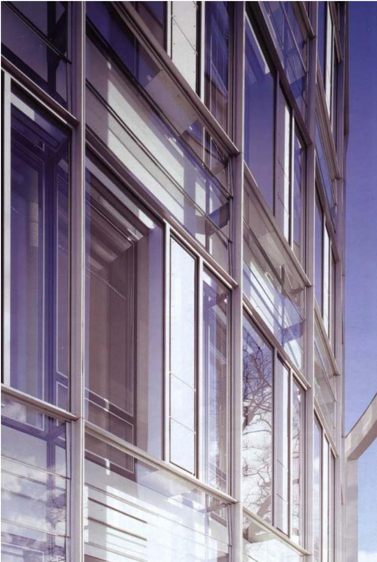
**Außenfassade** \* Die Außenfassaden als aufgestellte Pfosten-Riegel-Fassade (Achismaß 2500 mm) ist mit einer linear gelagerten Einfachverglasung ausgefacht. Der sich somit mit der Innenfassade bildende Zwischenraum ist aus Gründen der Unterbindung einer Schall-, Geruch- und Rauchausbreitung achs- und geschossweise mit vertikalen und horizontalen Glasschotten in der Art von Kästen unterteilt. Zur Wahrung der Transparenz sind alle Verglasungen der äußeren Hülle in Weißglas ausgeführt.
