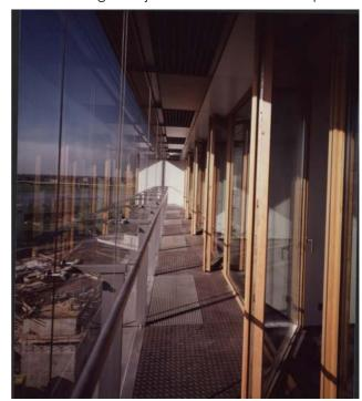
hierfür entwickelte Wendeflügel (rel. Luftdurchsatz bis 100%) zur Belüftung der Büros angesetzt, die außerdem den Zutritt zum Korridor ermöglichen.
